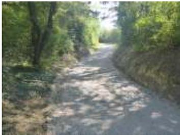
Um dem abtragen der Schotterdecke durch die Wassermassen entgegen zu wirken, haben wir uns entschlossen einige Teilstücke mit einer zweifachen Asphaltstutzdecke zu sanieren bzw. zu erweitern.
