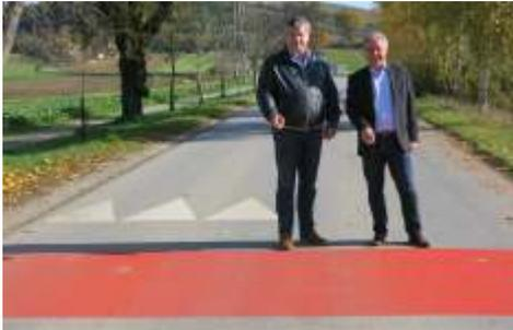
So wurde in Enzersdorf/Fischa nach Schaffung der Durchgangsmöglichkeit von der Franz Binder-Gasse zur Mittergasse an dieser Stelle eine Übergangshilfe (rote farbliche Fläche auf der Fahrbahn mit entsprechenden weißen Zusatzmarkierungen) samt Fußgänger-Piktogramme in beiden Fahrtrichtungen errichtet, um dort Fußgängern ein gesichertes Überqueren der Fahrbahn zu ermöglichen. In der Reisen-
