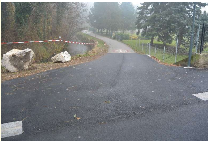
Ecke Bachgasse – Mühlstraße: Im Sinne der Barrierefreiheit wurde der Übergang abgeflacht
